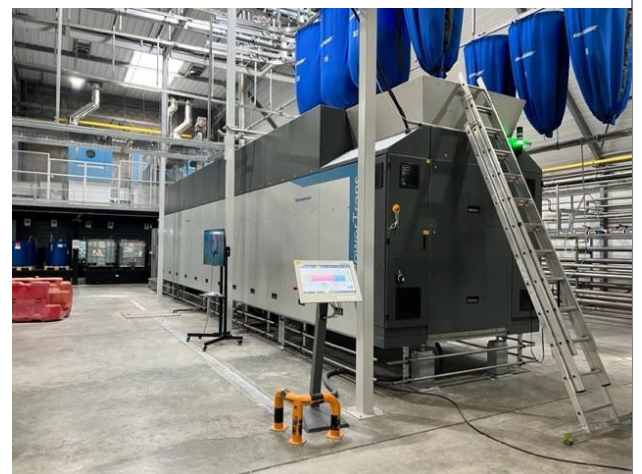
Tunnel de lavage
